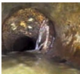
*Exemple d'une inspection télévisée : infiltration permanente d'eau claire. La Métropole investit pour le suivi en continu de ces défauts : 2451 mètres de réseau ont été complètement renouvelés (1,8 M€) et 7397 mètres de réseau réhabilités par l'intérieur par la technique de chemisage (1,0 M€).*
