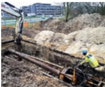
Travaux de transfert des effluents de Chambray-lès-Tours, du secteur situé à l'ouest de l'A10 vers la STEP de la Grange David : création d'un poste de refoulement pneumatique par havage et d'un refoulement sur un linéaire de 790 m avec forage dirigé sous la rue Philippe-Maupas. (400 000 €)
