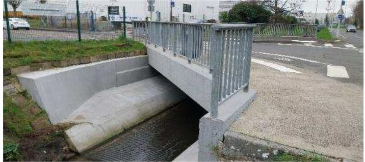
Les parties d'ouvrages accessibles seront nettoyées sous pression puis protégées par un produit d'étanchéité.
