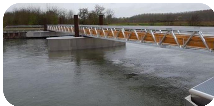
Figure 16: Exemple de passerelle flottante
