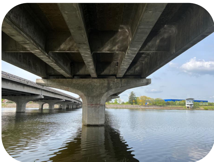
Figure 3: Pile marteau du pont d'Arcole
