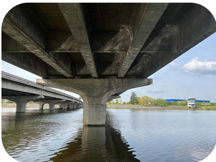
Figure 3: Pile marteau du pont d'Arcole
