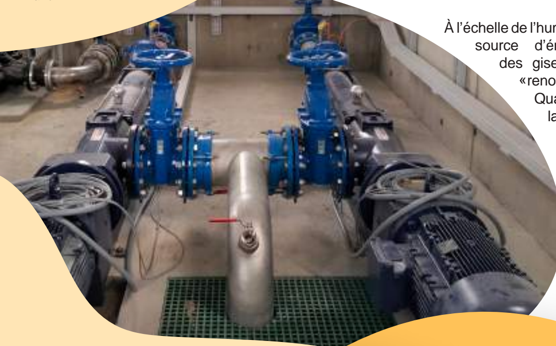
Pompe pour le process des boues de la station d'épuration de la Grange David
