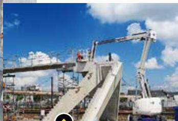
Mise en place d'un escalier sur une culée d'extrémité.
