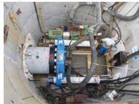
Vue du puits de poussée du microtunnelier de 800 mm de diamètre qui va permettre le raccordement des collecteurs communaux existants. (Doc. Tour(s)plus.)
