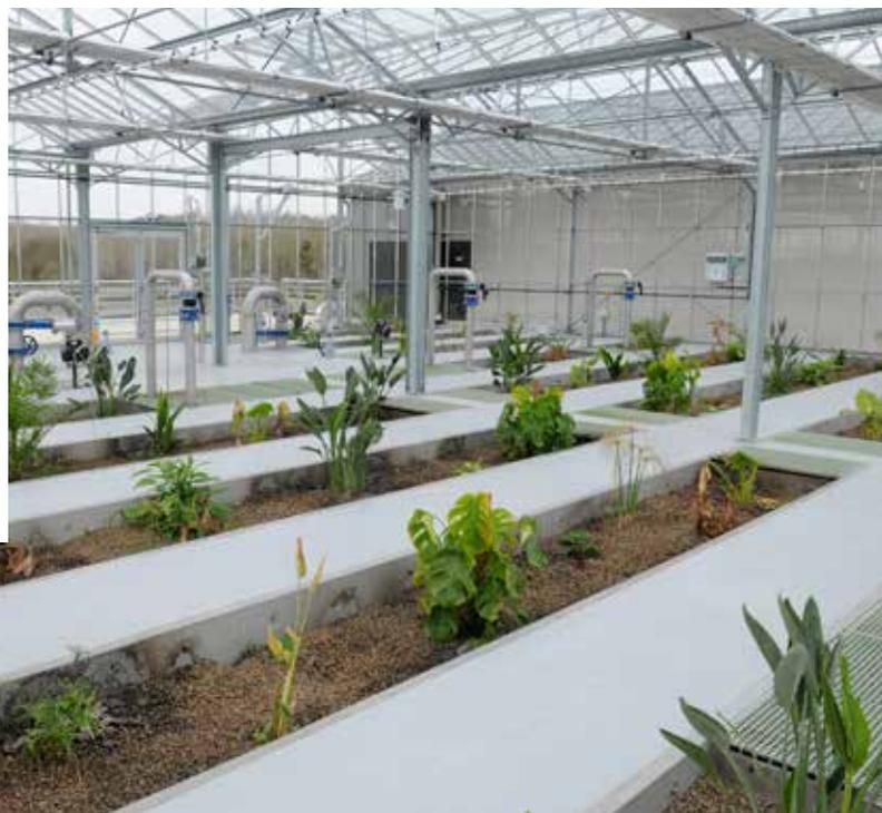
La station d'épuration nouvelle génération est en cours d'achèvement. Exit l'ancienne unité, arrivée à saturation, et place à une station écologique qui assure la dépollution des eaux usées par des plantes exotiques.
