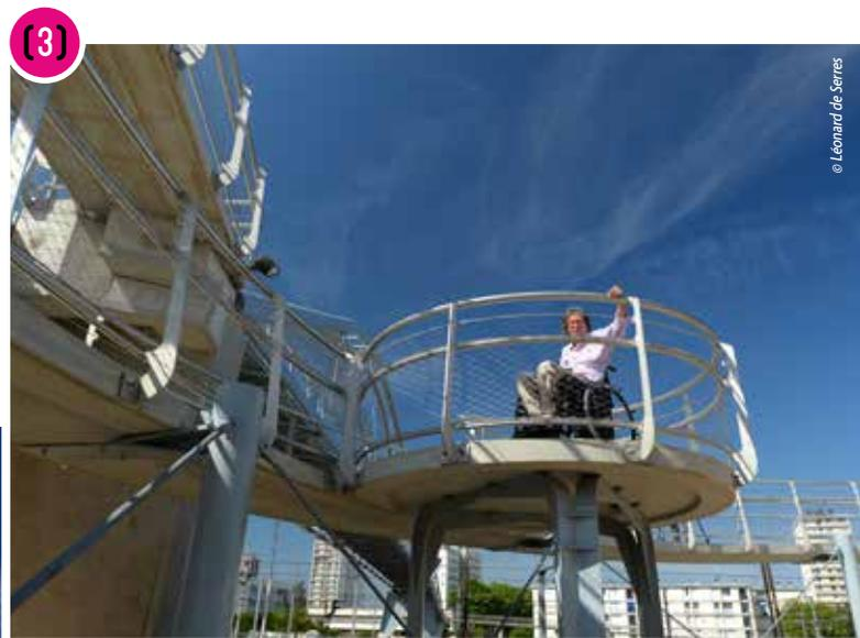
Sur l'ancienne passerelle, il fallait porter son vélo sur son dos... Sur la nouvelle, la rampe hélicoïdale côté Velpeau et la rampe droite côté Sanitas, larges d'1,40 m avec une pente à moins de 4 % permettent de circuler (à vélo, mais aussi en fauteuil ou avec une poussette). L'APF (l'Association des Paralysés de France) a obtenu la mise en place d'une plate-forme de repos à mi-hauteur (Patrick Leproust, de l'APF la teste sur la photo 3).
