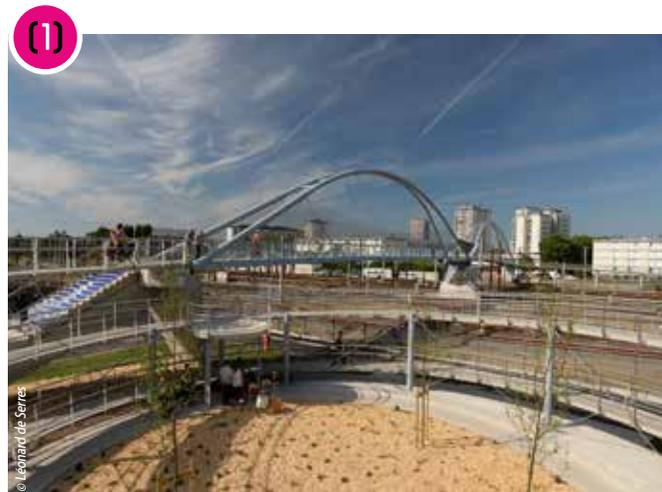
Plus d'un an de travaux aura été nécessaire pour remplacer le vieil ouvrage métallique, mis en service en 1891 (et reconstruit après la Seconde Guerre mondiale) par l'aérienne passerelle de 120 m, aux deux arcs tendus de 60 m de portée, qui relie le quartier Velpeau à celui du Sanitas, au-dessus des voies ferrées et qui voit circuler chaque jour plus de 800 personnes.
