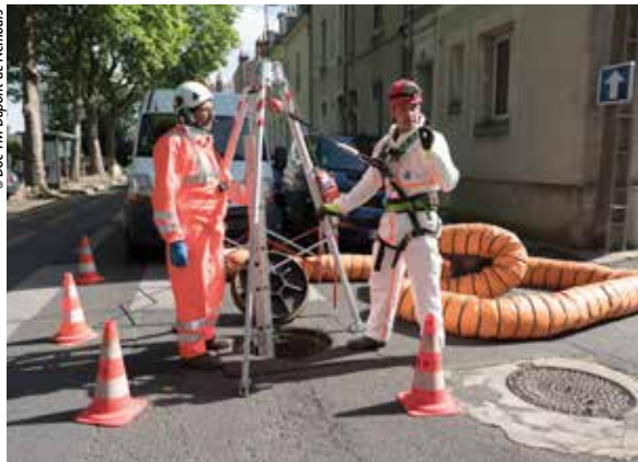
Franck Deruelle effectue une prise de mesure en 3 points avec un détecteur de gaz avant de pénétrer dans l'ouvrage
