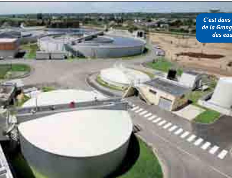
C'est dans les grands digesteurs de la station d'épuration de la Grange David que les déchets résultant du traitement des eaux usées sont réduits et deviennent du biogaz
