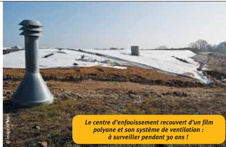
Le centre d'enfouissement recouvert d'un film polyane et son système de ventilation : à surveiller pendant 30 ans !
