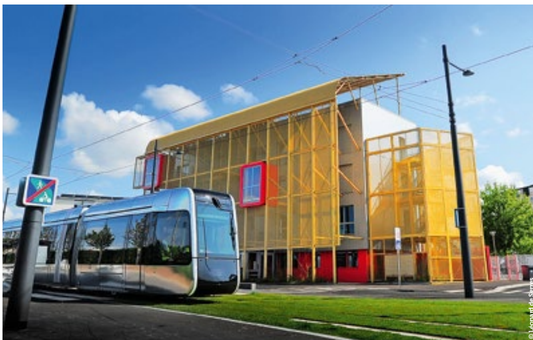
La pépinière d'entreprises de Joué-lès-Tours.
