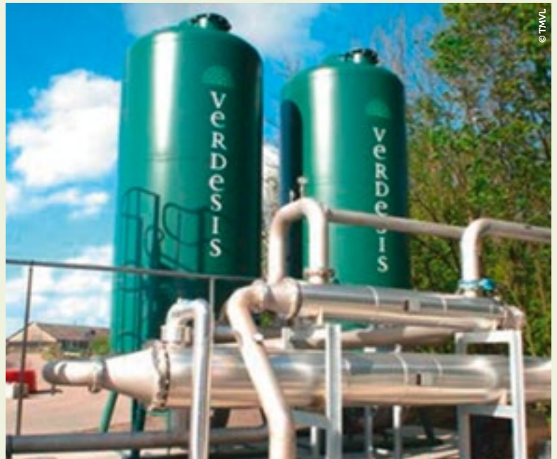
La station d'épuration des eaux urbaines de la Grange David à La Riche.
