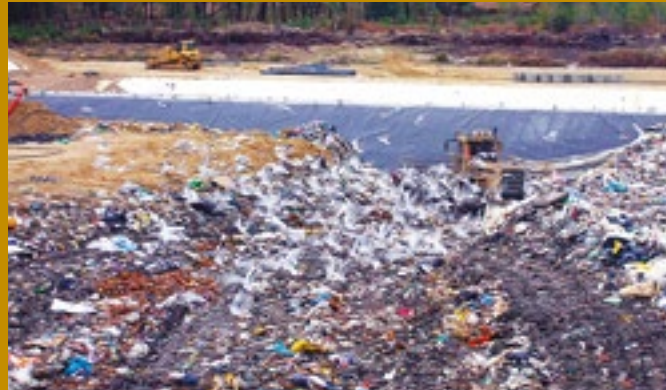
▼ Tassage des déchets au centre de stockage de Sonzay
