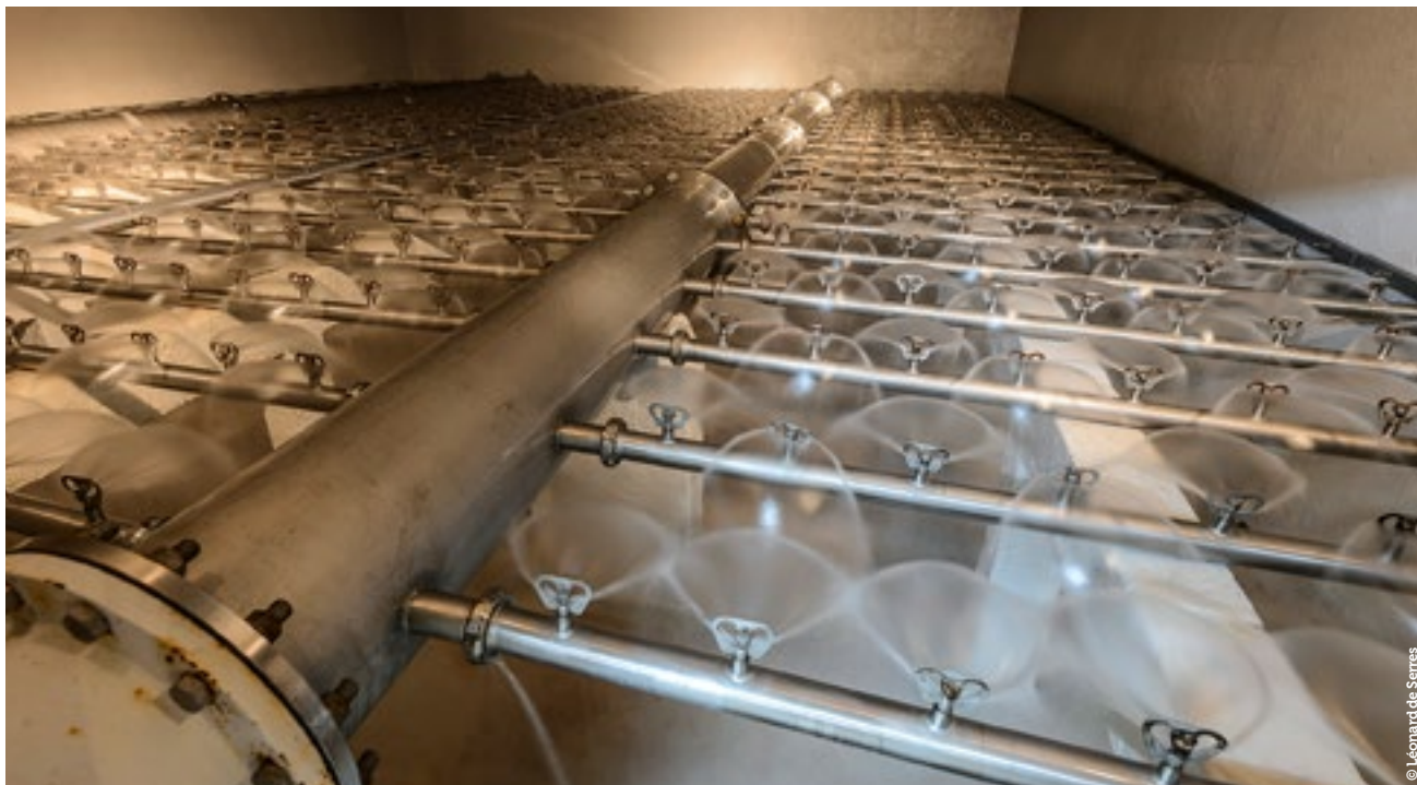
Étape de traitement (oxydation à l'air) de l'eau potable dans l'usine Quai Portillon à Saint-Cyr-sur-Loire.
