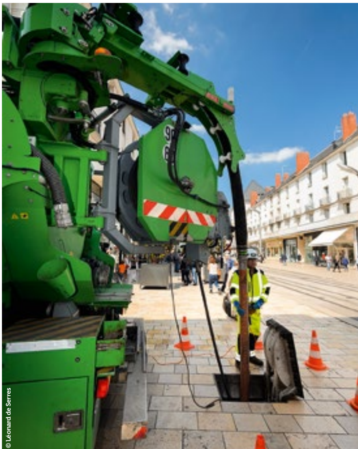
Opération de curage des réseaux d'assainissement, rue Nationale à Tours.
