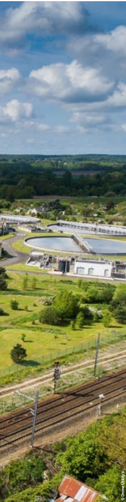
Station d'épuration e la Grange David à La Riche.
