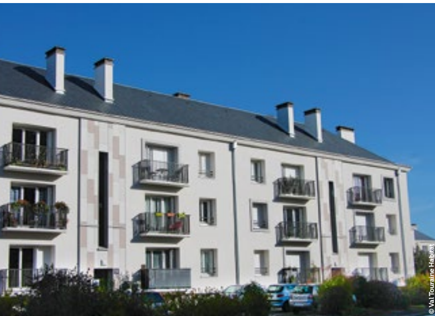
Rénovation de La Mésangerie à Saint-Cyr-sur-Loire.
