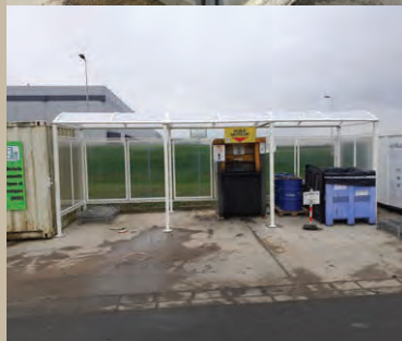
Déchèterie du Cassantin
