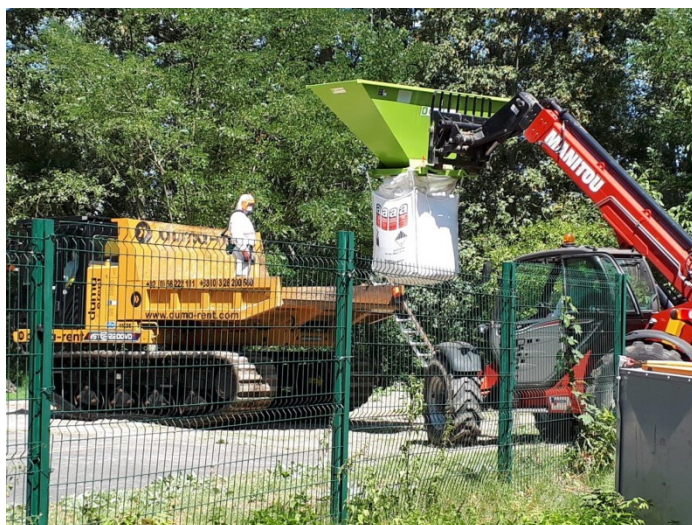
(opération de retrait et d'évacuation des terres polluées et évacuation par un passage à gué)
