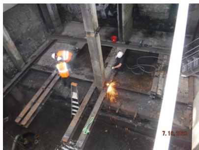
Démontage support pied d'assise
