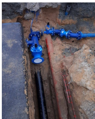
Chantier Tours Centre 2020 : Bouclage air comprimé et renouvellement AEP
