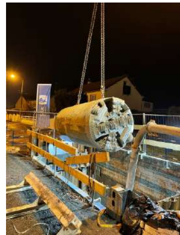
Retrait du micro-tunnelier
