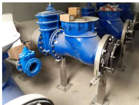
Pose de vannes au poste Sud
