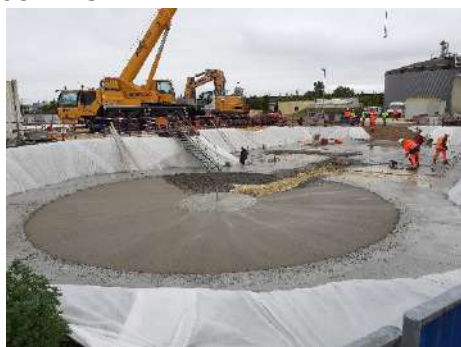
Travaux de la bâche à boues
