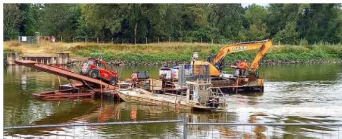
(amenée du matériel par voie fluviale)
