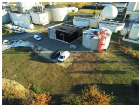
Travaux local pompe à chaleur
