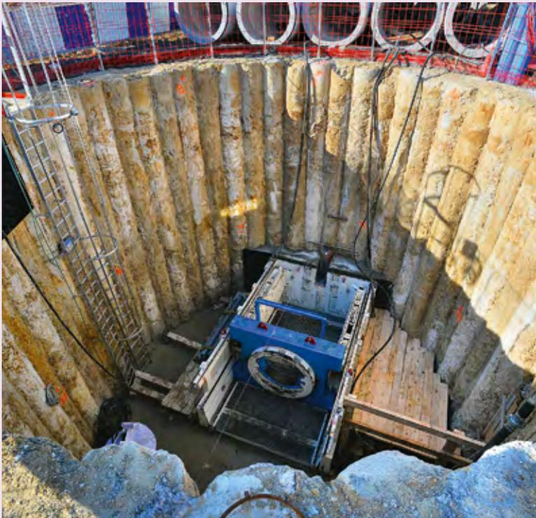
**De haute technicité, les travaux réalisés rue de Suède et avenue Gustave Eiffel ont nécessité d'ouvrir la chaussée sur plus de 3,5 kms et de faire intervenir un micro-tunnelier pour forer et créer un réseau situé à plus de 7 mètres sous terre.**
