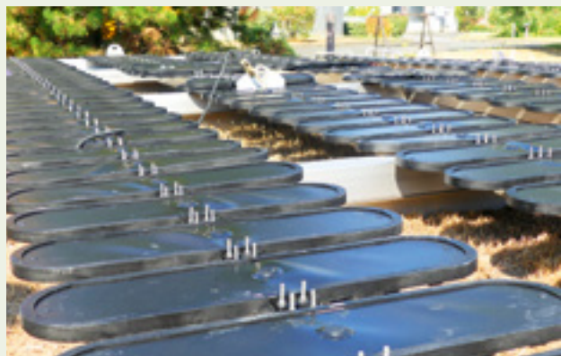
Travaux d'efficacité énergétique à la STEP de la Grange David (La Riche).
