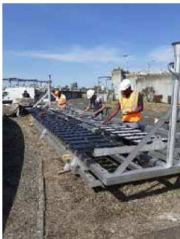
Installation des diffuseurs sur les nouvelles raquettes
