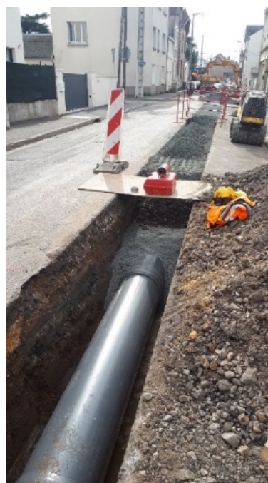
Pose d'un collecteur EP de Ø 500 mm rue Audenet à Saint Pierre des Corps
