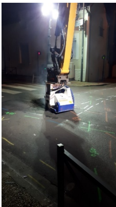
Travaux de nuit avec remise en état de la voie chaque matin
