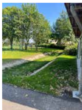
Camping de Savonnières – Gestion des eaux pluviales de l'accueil
