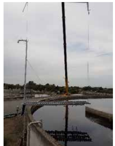
Installation des raquettes dans les bassins biologiques par le biais d'une grue
