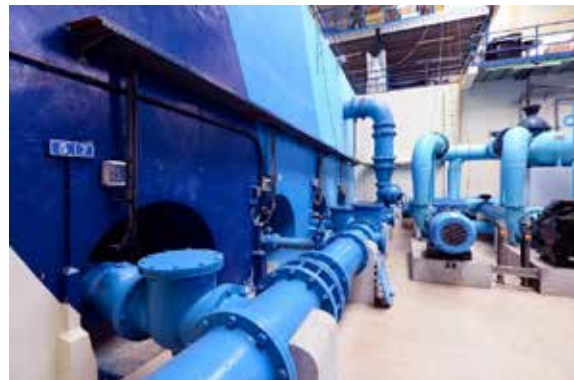
(Station de pompage de l'île Aucard)
