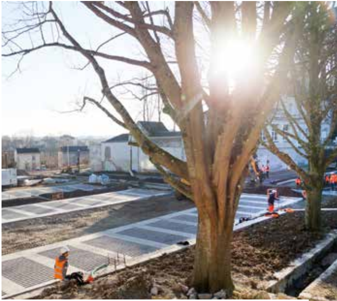
Coût des travaux pour la création du parking avec ses annexes : 1 300 000 € TTC (financement conjoint Métropole et Ville)
