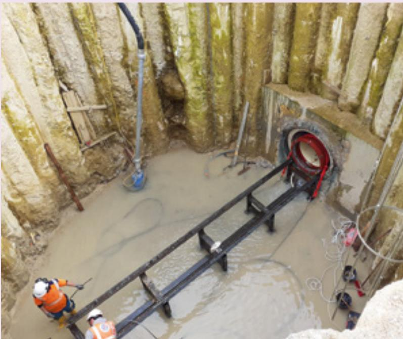
De haute technicité, les travaux réalisés rue de Suède et avenue Gustave Eiffel ont nécessité d'ouvrir la chaussée sur plus de 3,5 kms et de faire intervenir un micro-tunnelier pour forer et créer un réseau situé à plus de 7 mètres sous terre.
